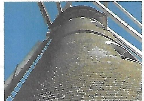
14 De molen is onlangs opnieuw gevoegd. Evens is er een goot onder kap aangebracht.
