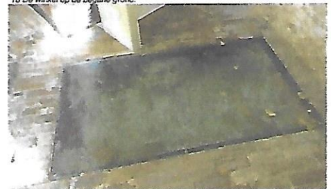
17 Bij het herstel van de fundering zijn de teelringen van de oude standerdmolen aan het licht gekomen.
