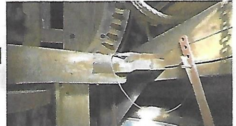
30 De jaerbalk is eigenlijk iets te kort. Hierdoor is een zwaar wiggenpakket nodig.
