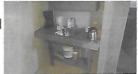
5 De doorslag t.p.v. de pantry op de 1e zolder.
