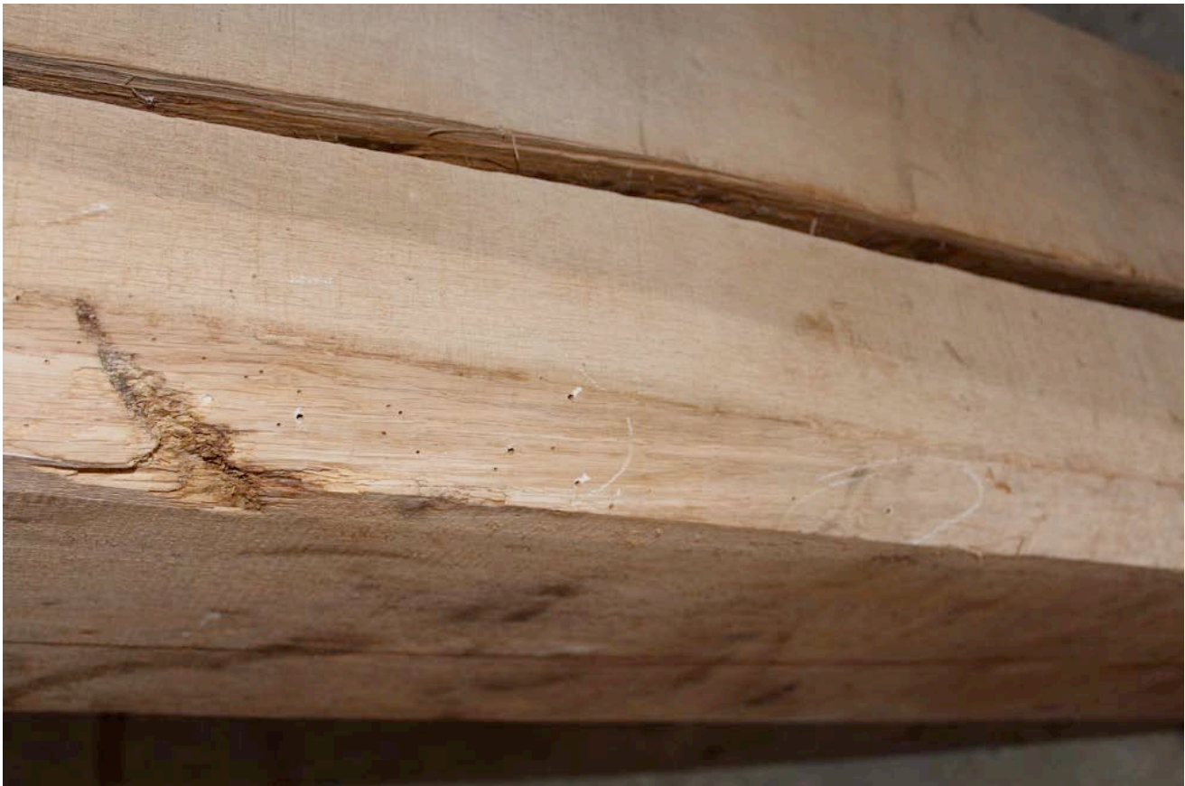
De draagbalk van de koning vertoont aantasting door bonte knaagkever.
