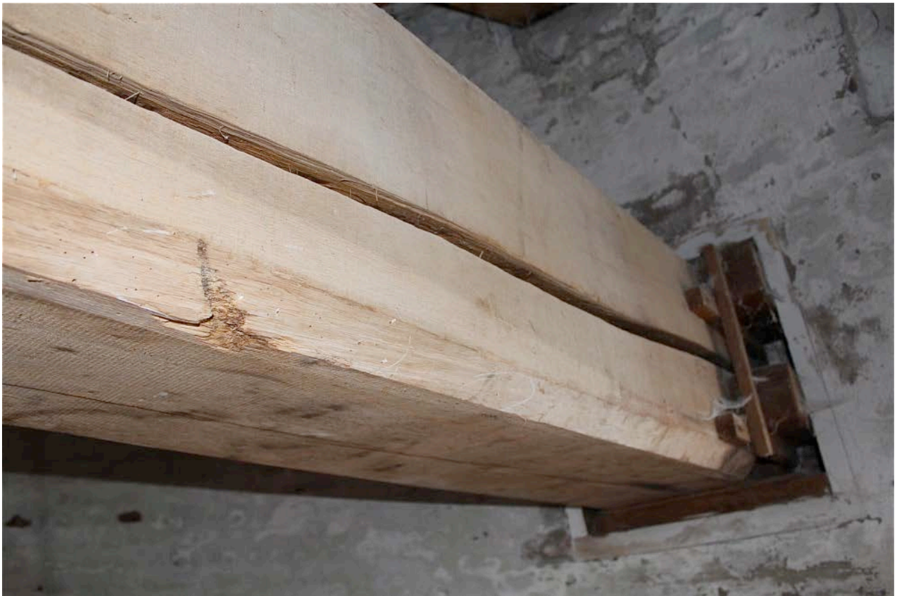
De draagbalk van de koning is gescheurd.
