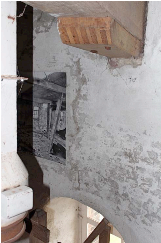
Er bevinden zich enkele scheuren in de romp. Alleen de scheur op de 3 e zolder behoeft herstel.
