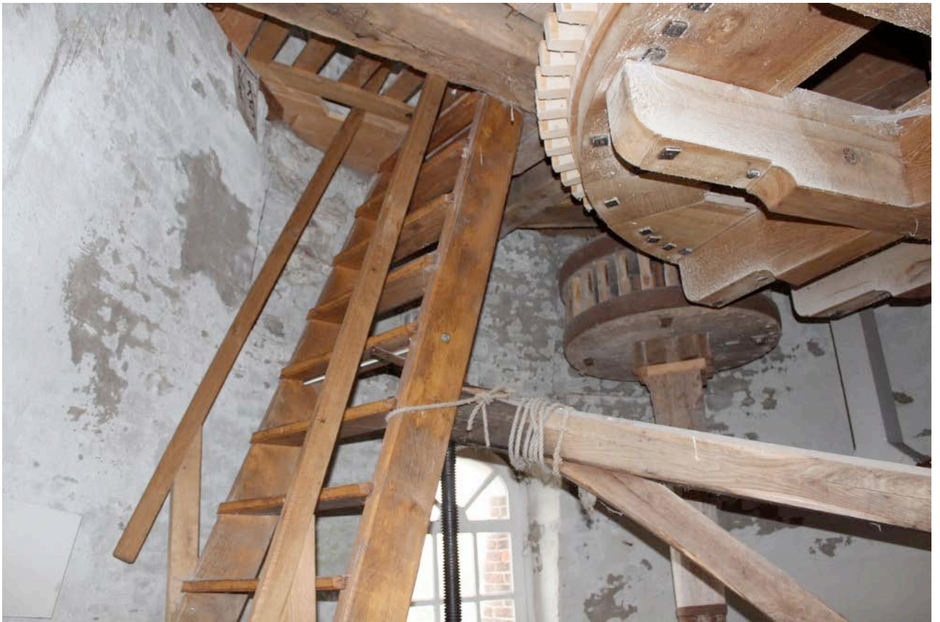
Het pleister en witwerk in de hele molen behoeft onderhoud.
