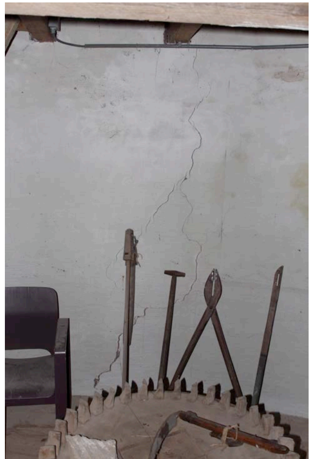
Er bevinden zich enkele scheuren in de romp. Alleen de scheur op de 3 e zolder behoeft herstel.
