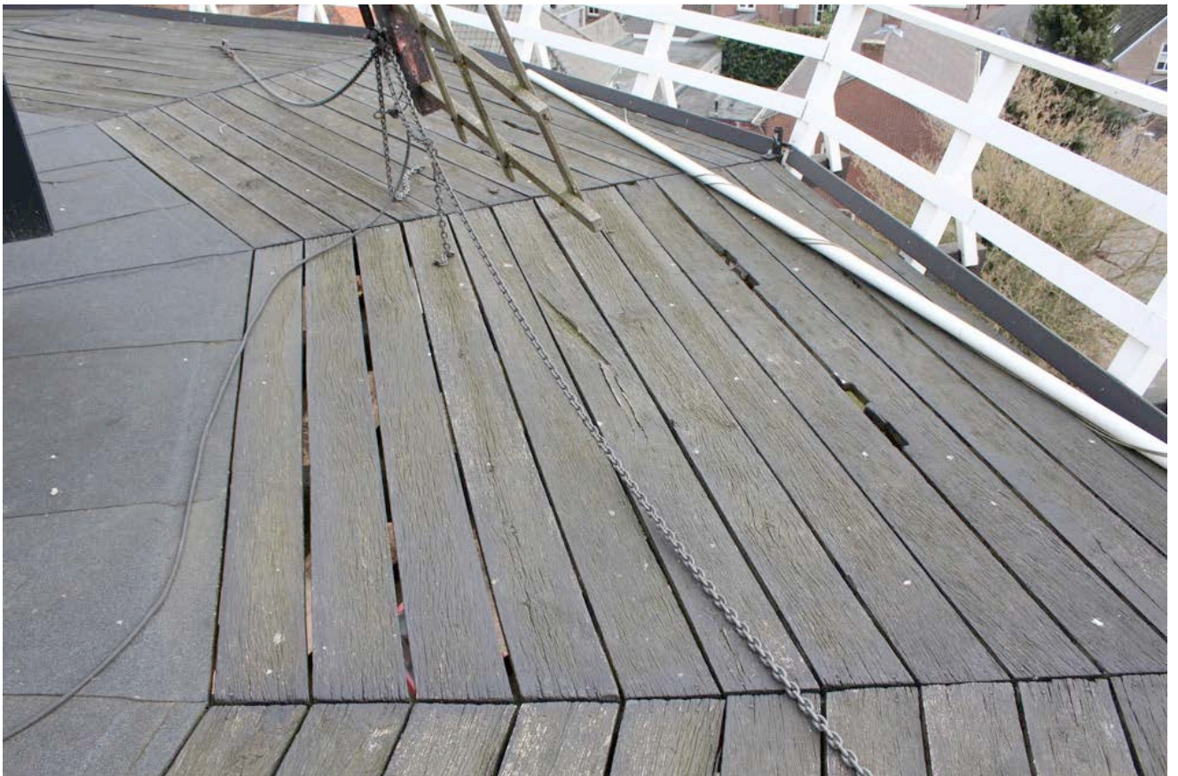
De stellingplanken van gewolmaniseerd eiken vertonen hier en daar zachte plekken op de koppen. Grootscheeps herstel is echter in de komende 6 jaar nog niet nodig.
